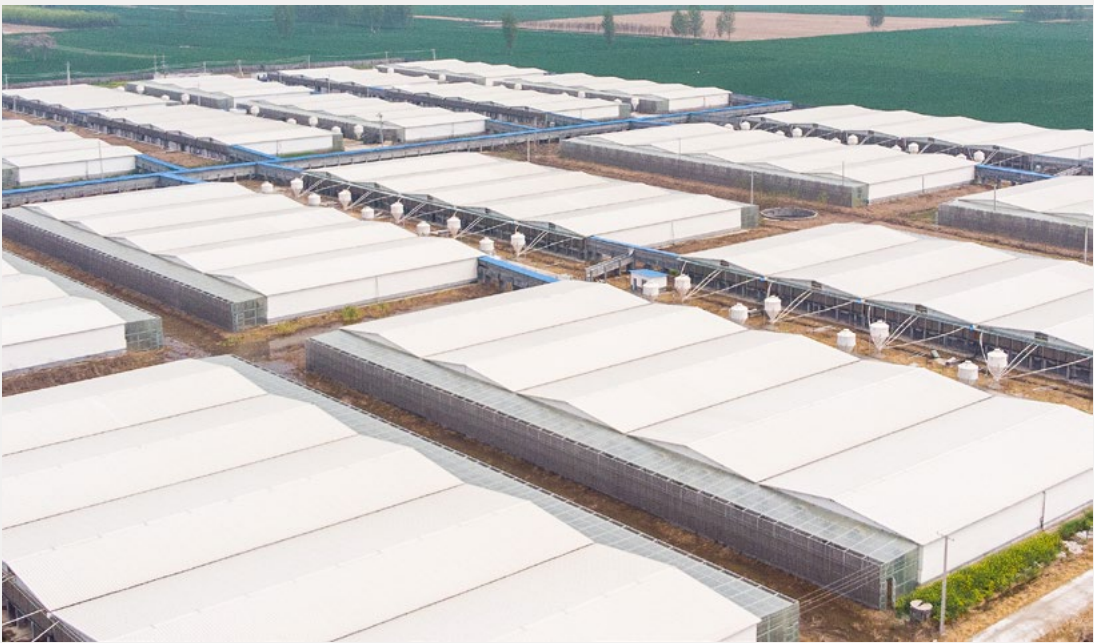
除臭墙 + 雾化喷洗
