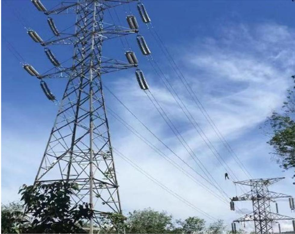
150kv输电线路架线施工中
