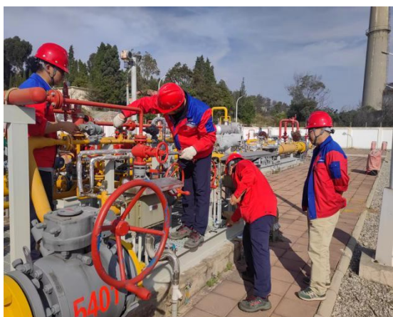
天然气安宁末站对管道开展安全检查
