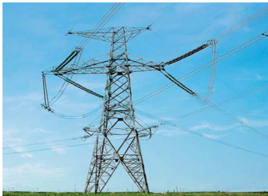
作为架空地线（最上方的2根避雷线）
