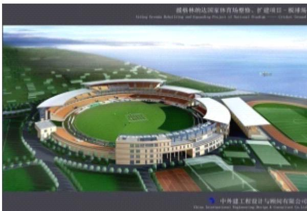
**格林纳达国家体育场**，由中国政府援建的国家重点项目，桁架悬挑钢结构 63 榀梁，主钢结构为管桁架结构，建筑面积 20,000 平方米。公司为该项目提供钢结构件数量约 3,000 吨，金额 989 万元。（公司提供钢结构制作）
