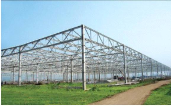
**江苏东风悦达起亚工程**，用钢量近 10,000 吨，建筑面积 7 万多平方米，主钢构件最长 26 米、重 11 吨。公司为该项目提供钢结构数量约 3,084 吨，金额 1,252 万元。（公司提供钢结构制作）
