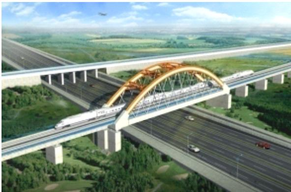
**京沪高铁跨青阳港桥工程**，整个桥梁成弧形，跨度达 96 米，钢梁箱按纵向分 14 段，每段长 9 到 15 米不等，最重 25 吨，最小的也有 15 吨。公司为该项目加工制作钢结构数量约 1,293 吨。（公司提供钢结构制作）
