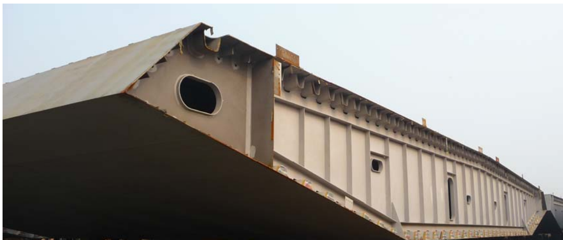
图例：泰州长江大桥钢箱梁钢结构
