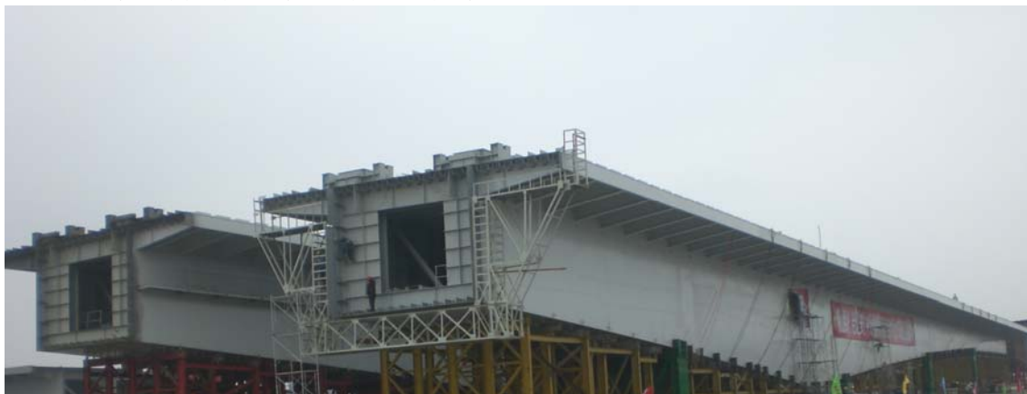
图例：崇启长江大桥钢箱梁结构
