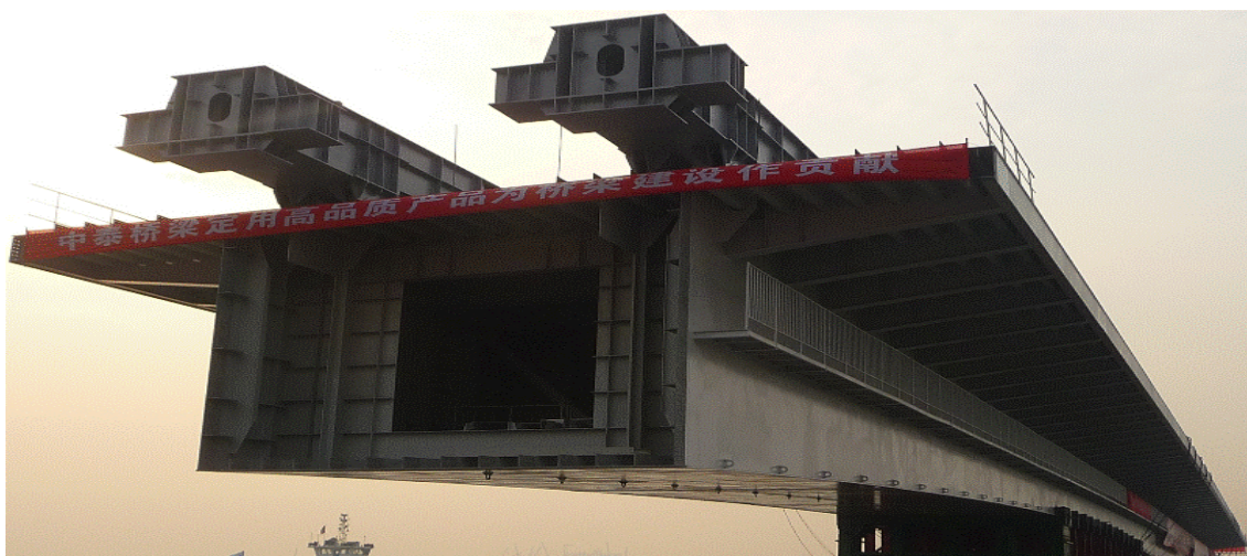
图例：崇启长江大桥钢箱梁结构
