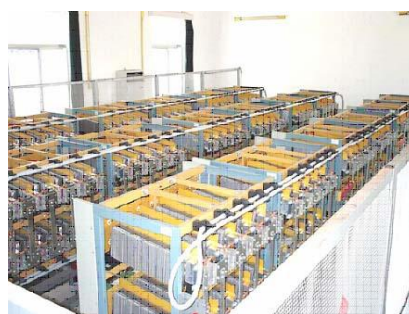
SVC 的晶闸管变流阀组
