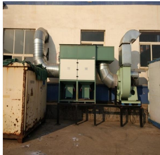
烟台来福士焊接车间的烟尘收集净化系统
