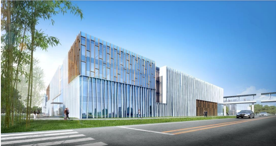
中集模块化承建的前海创新商务中心 A、B 组团完工
