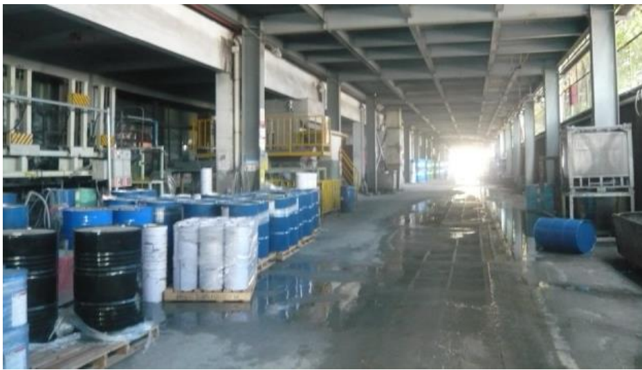
南方中集水性漆生产线改造
