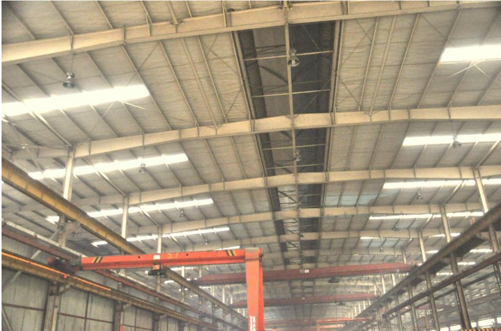
西安中集屋顶自然采光
