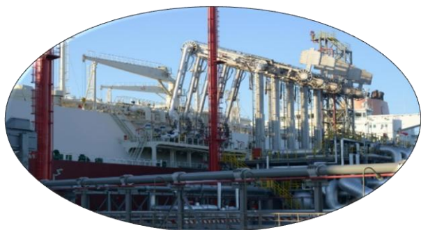
图 1：唐山 LNG 接收站
