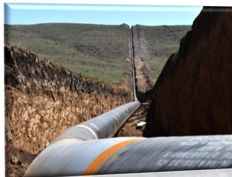
图 2：北京天然气管道户外施工-1
