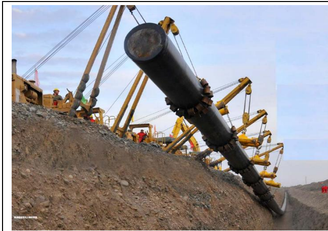
图 8：中亚天然气管道建设 3
