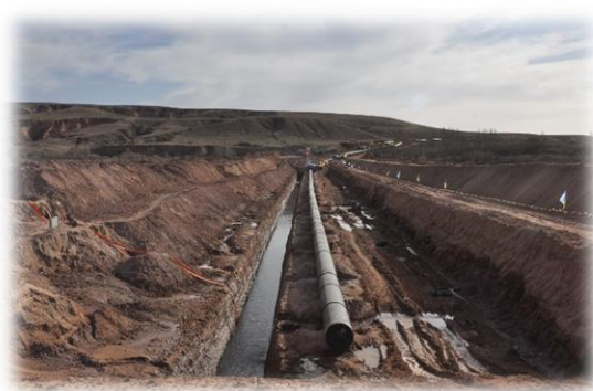
图 4：北京天然气管道户外施工-3
