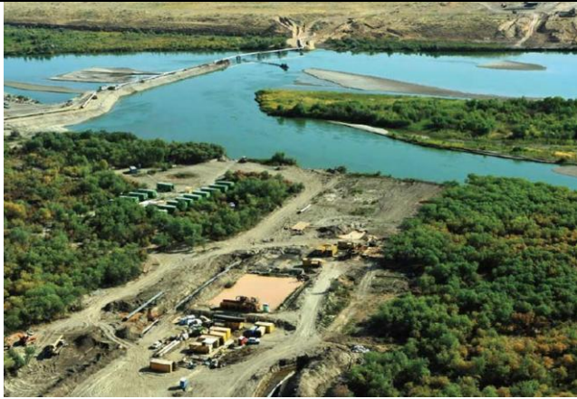
图 6：中亚天然气管道建设 1
