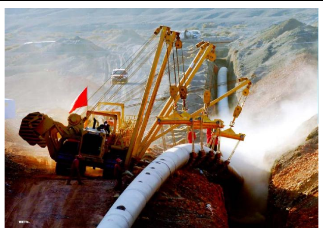
图 7：中亚天然气管道建设 2
