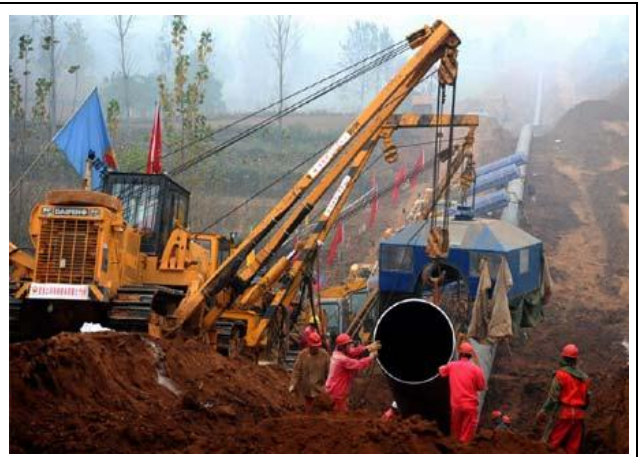
图 9：中亚天然气管道建设 4
