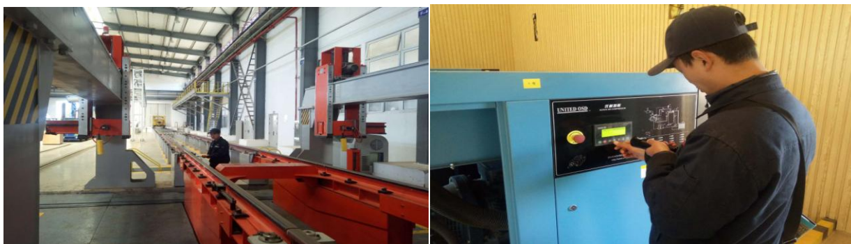
图：动车所维保现场
