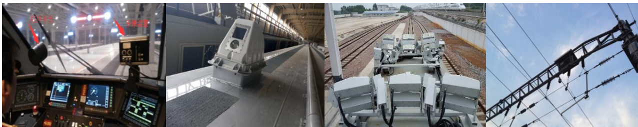
图：供电安全检测监测系统
