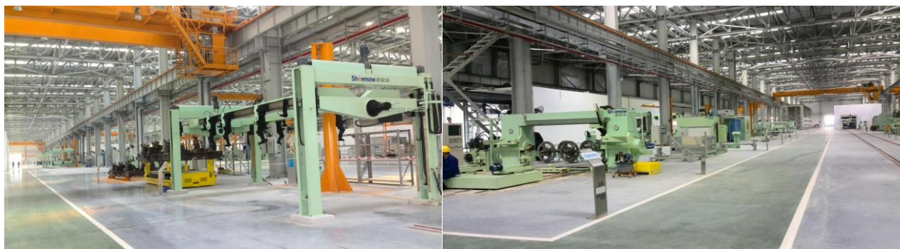
图：大功率机车检修基地
