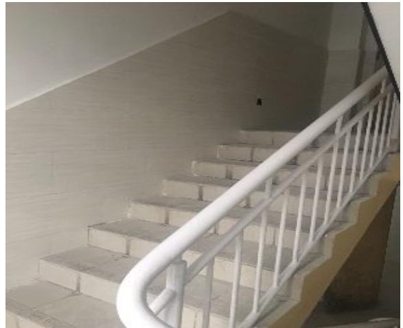
宿舍整改之楼梯粉刷
