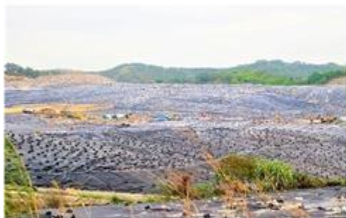
垃圾填埋覆盖
