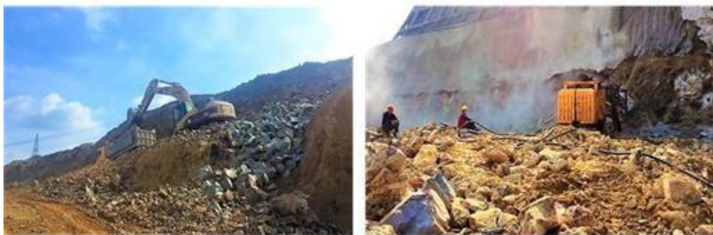
土石方开挖施工
