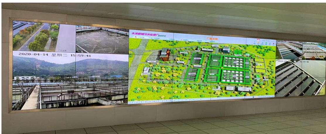
图：苏州市吴中区木渎新城污水处理厂委托运营项目
