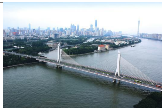
广州海印桥 (中国建设工程鲁班奖)
