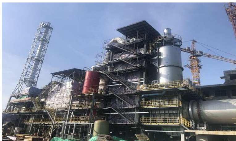
海南洋浦港危险废物处理中心项目
