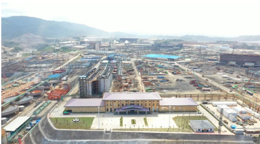
印尼镍资源项目建设现场
