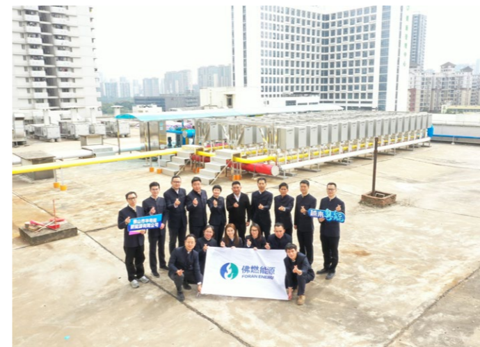
市一医院 1 号楼热水天然气节能改造
