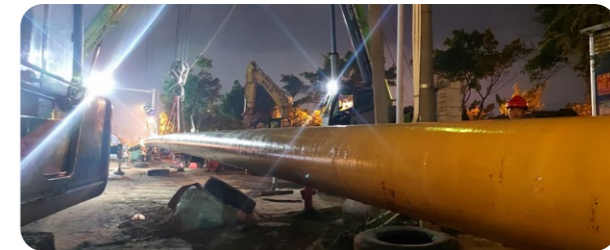
佛山 - 清远天然气高压管网互联互通工程现场
