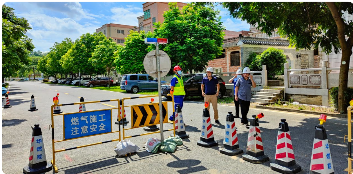
佛山禅城村头村天然气管道工程现场
