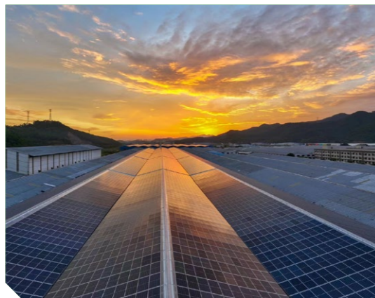
佛山高明贝斯特陶瓷有限公司 5112.72kWp 分布式光伏发电项目
