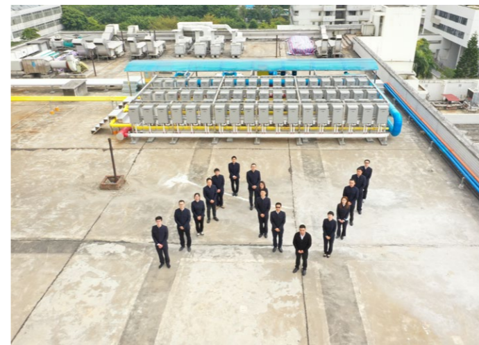
市一医院 2 号楼热水天然气节能改造
