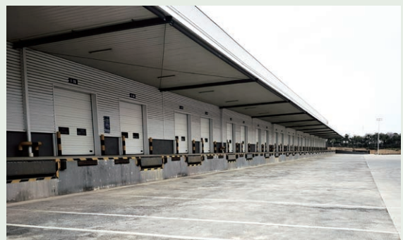
南宁园区透水混凝土工艺
