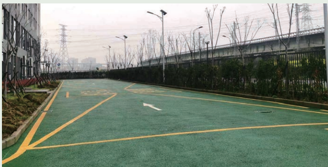
杭州园区透水混凝土工艺
