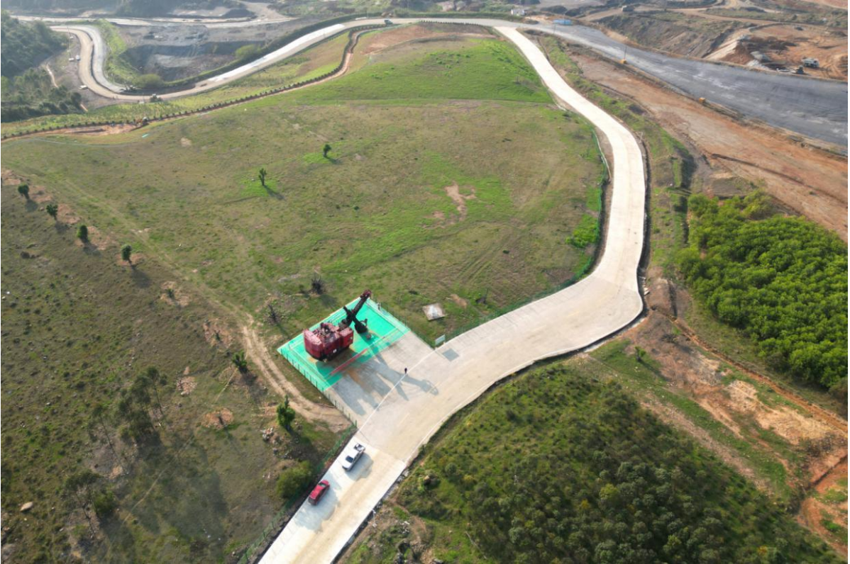
矿山公园（建设中）
