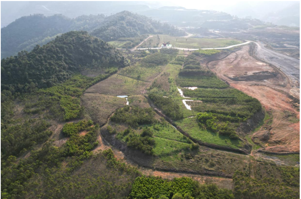
排土场 430 台阶绿化全景
