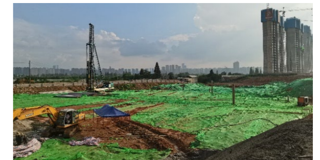
覆盖裸露场地
