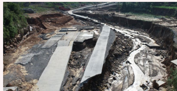
郑州公司进行道路恢复作业
