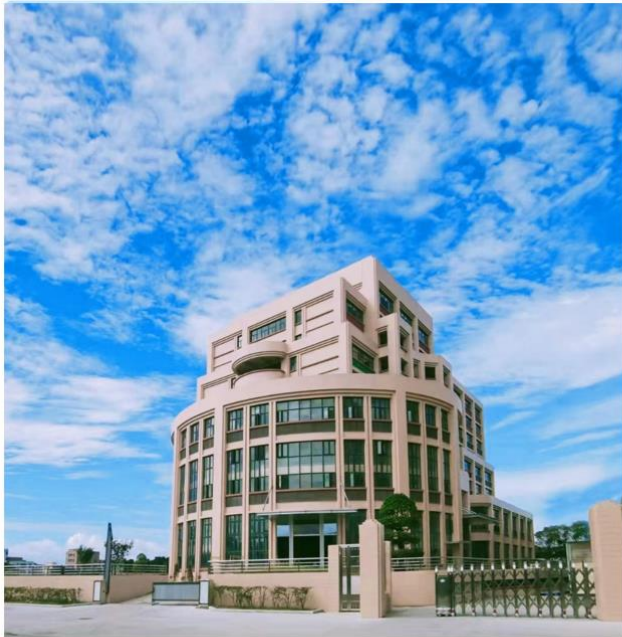
上图：妇产医院综合大楼
