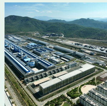
云铝溢鑫光伏项目
