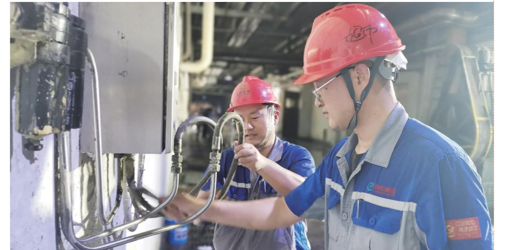
▶ 公司安全隐患排查现场
