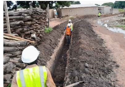
马里锂业支持本地基础设施建设
