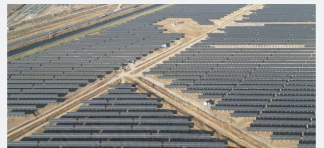
中节能滨海太平镇 300MW 光伏复合发电项目获评安全环保标准化示范工地
