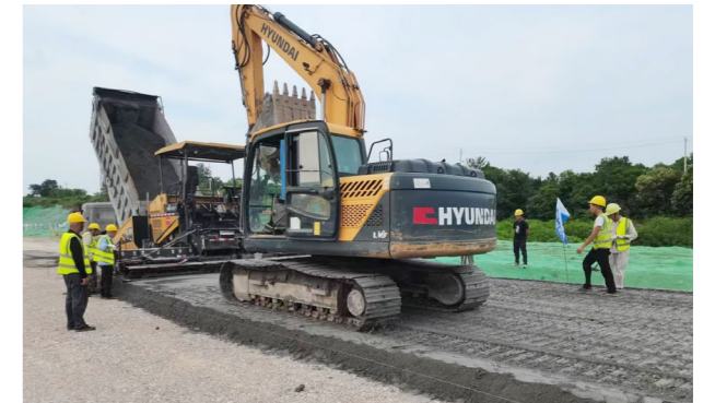
荆东大道使用磷石膏路基材料路段
