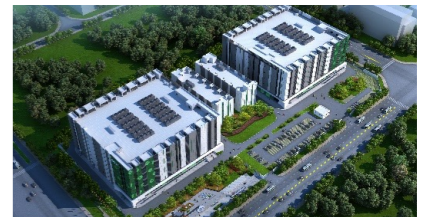
合盈数据（怀来）科技产业园数据中心
