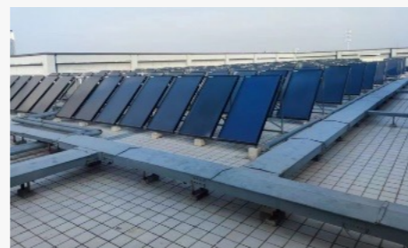
■ 铺设 1,100 平米太阳能集热板
