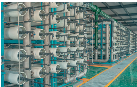
▼ 荆州公司循环水排污水处理反渗透系统与结晶造粒系统
