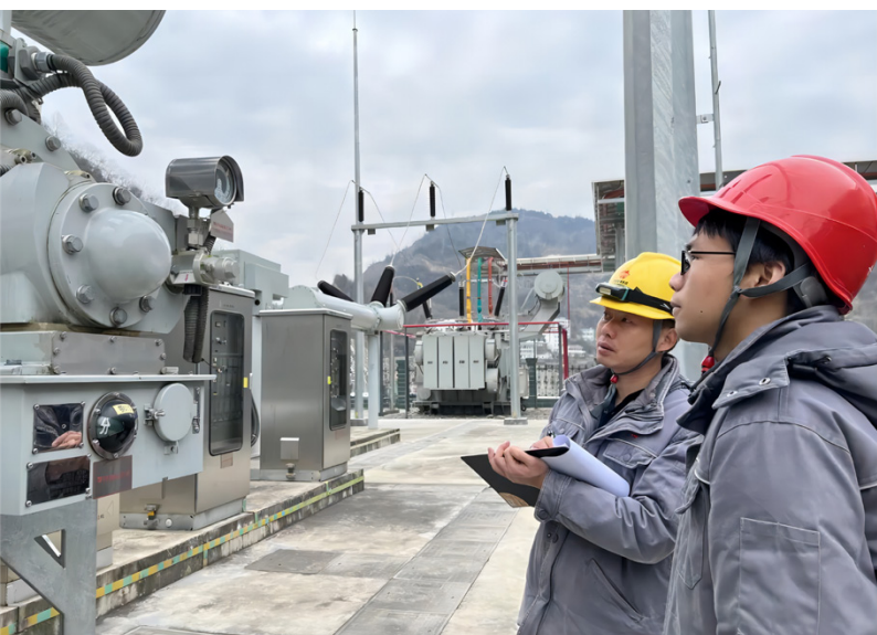
▼ 十堰公司对发供电设备进行隐患排查
