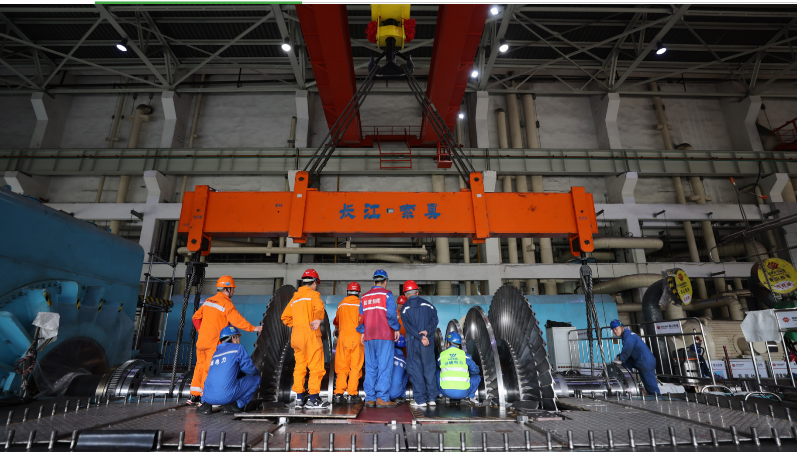
▼ 青山公司高质量完成 #13 机组通流改造，供电煤耗比改造前下降 20 克 / 千瓦时
