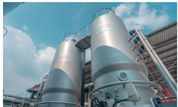
▼ 荆州公司循环水排污水处理反渗透系统与结晶造粒系统
