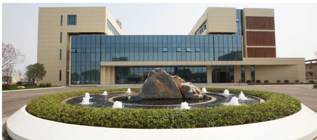
技术中心研发大楼
