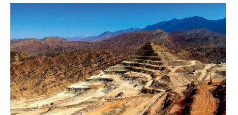
爆破工程项目
