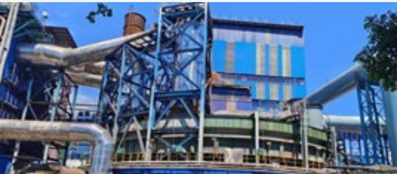
烧结环冷机水密封
