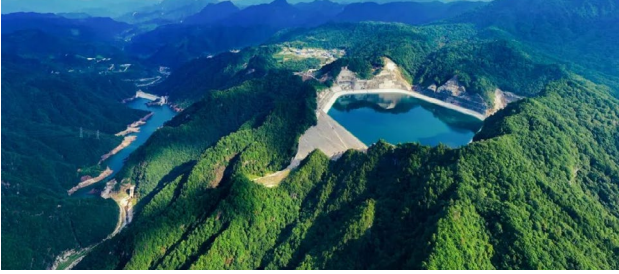
压力管道用钢供货“一带一路”重大水电工程 陕西镇安抽水蓄能电站
