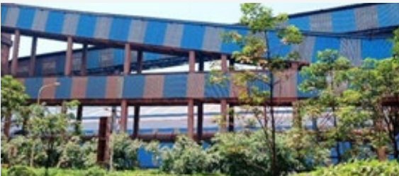
皮带通廊封闭
