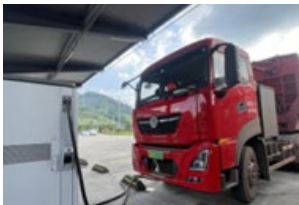
充电装置使用现场
