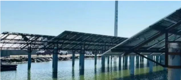
海洋光伏用高耐蚀型耐候钢供货华能滨州 85 万千瓦光伏发电项目
