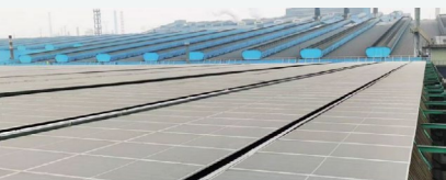
华菱湘钢宽厚板厂屋顶光伏项目
