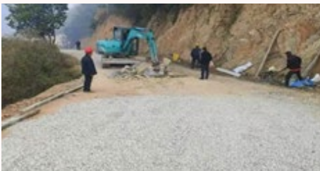
乡村公里道路扩宽中
