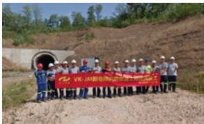
VK-JM 矿新旧排洪洞贯通工程、排洪洞封堵工程
