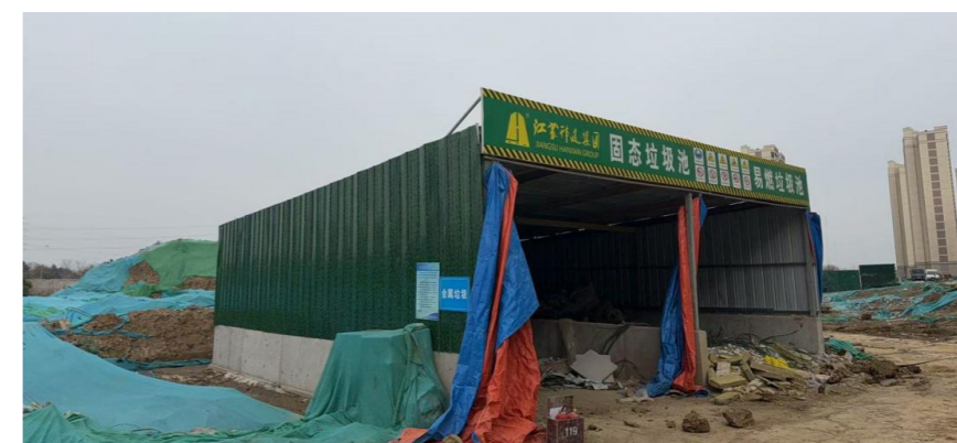
扬州数智城项目施工现场建筑垃圾集中回收池
