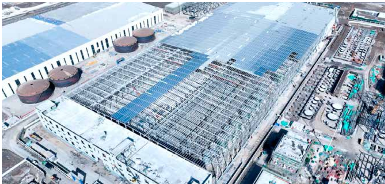
图 15 4万吨/年基础锂盐一体化项目建设俯瞰图
