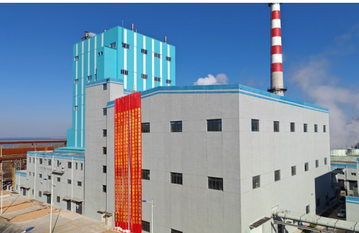
鲅鱼圈钢铁分公司 135MW 超临界煤气发电机组项目工程
