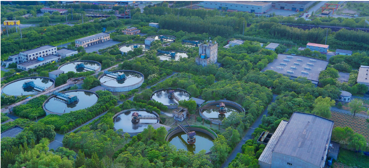
西大沟污水处理
