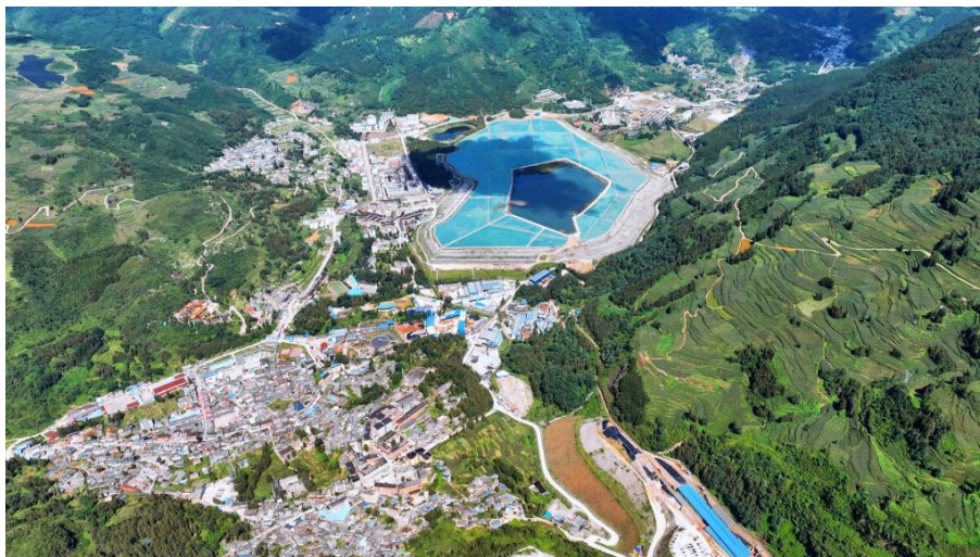
卡房尾矿库闭库治理工程
