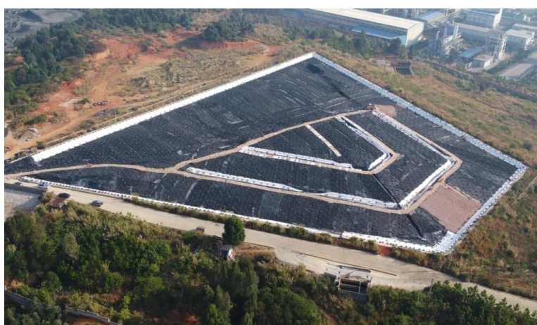
锡业股份危险废物填埋场
