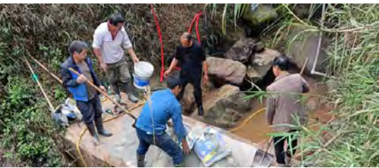
重庆公司羊鹿山隧道节水施工
