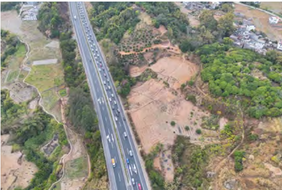
无人机巡航巡检现场
