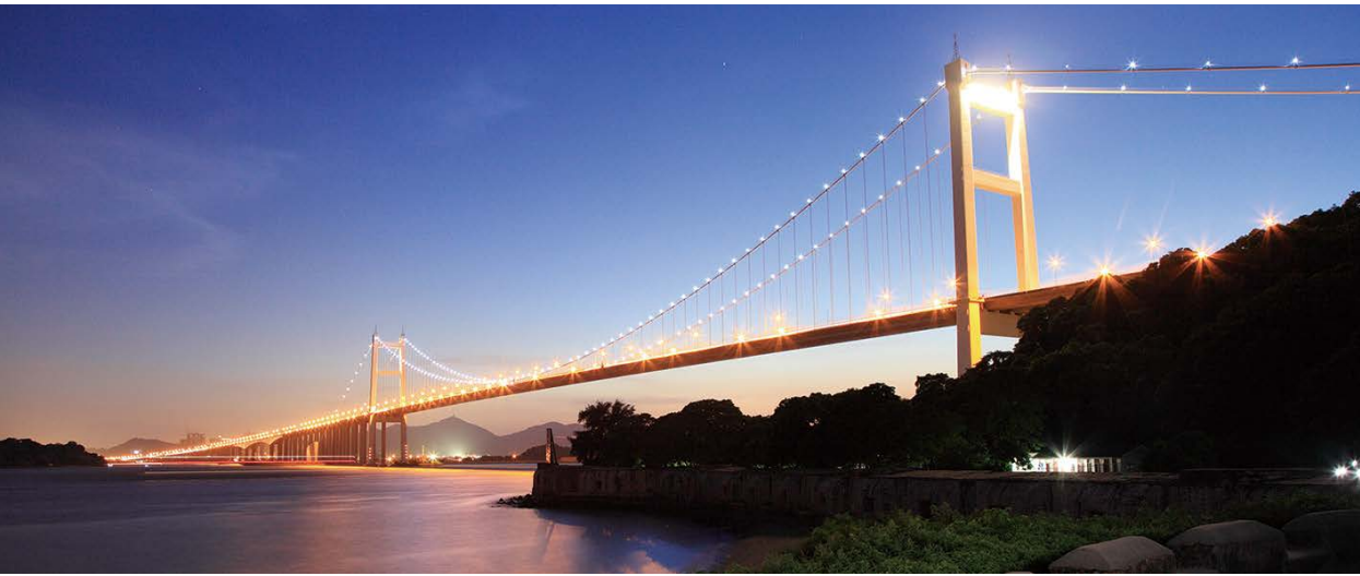
虎门大桥主缆
