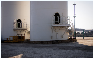
废旧钢板制作的塔筒安放鞍座
