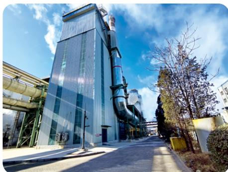
热电及背压发电机组增加脱硫设施项目
