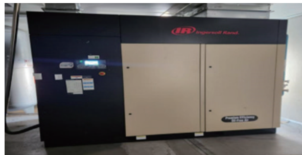
图：变频空压机
