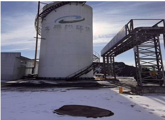
图：污水厌氧反应器
