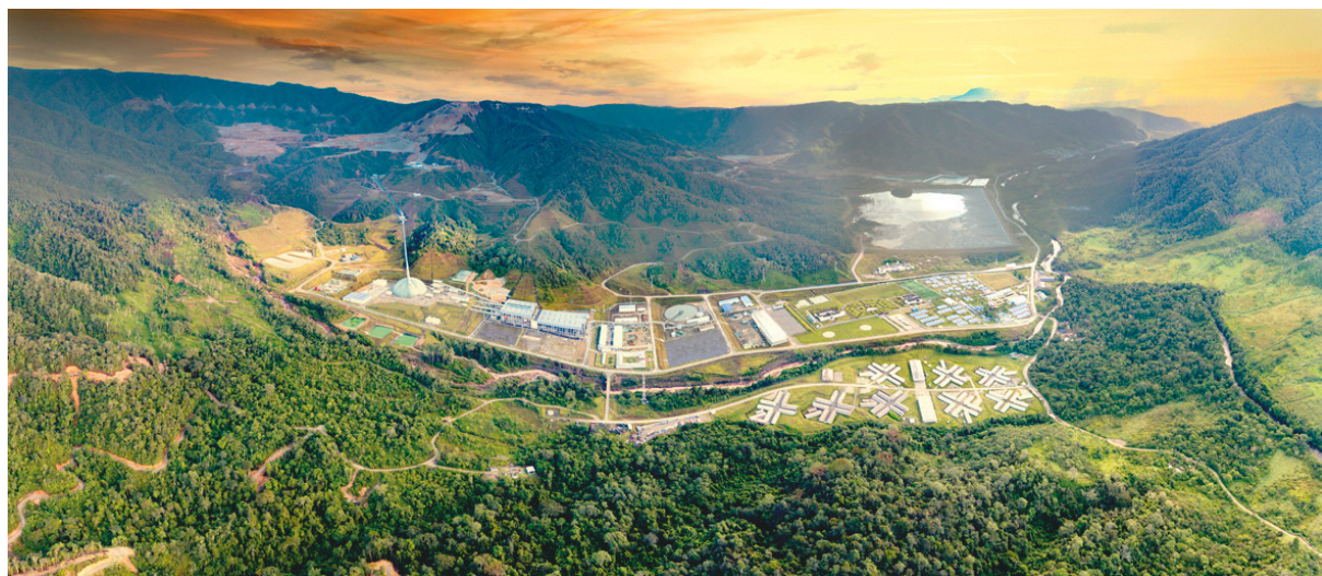
米拉多铜矿全貌
