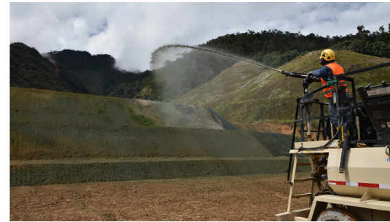
米拉多铜矿实施喷播复垦作业
