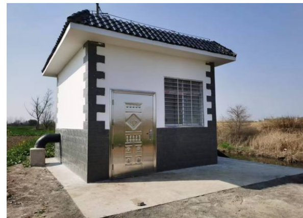
新修抗旱泵站
