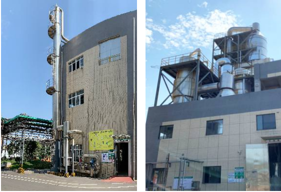
荆门园区“汽提+膜+MVR”组合技术
