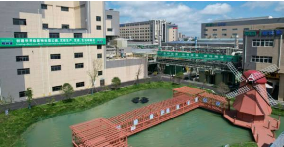
格林美（荆门）园区废水治理设施“三个再造”
