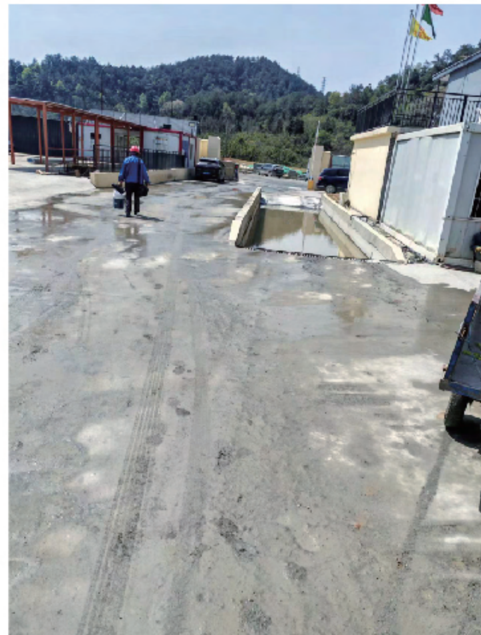
图：清洗工地进出车辆
