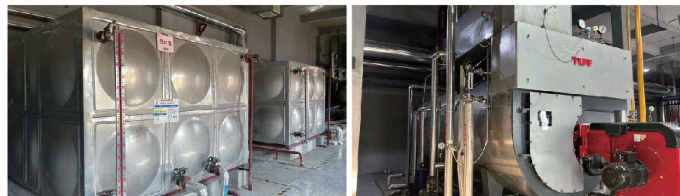
图：蒸汽冷凝水循环利用系统
