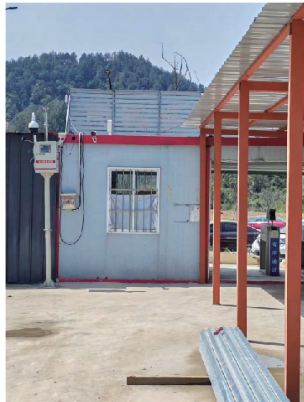
图：安装扬尘在线检测装置
