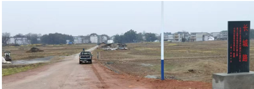
江西遂川零田镇坊坑村道路建设
