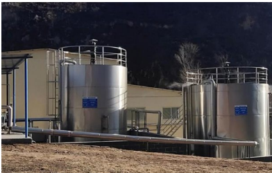
金恒公司硝酸铵溶液储罐
