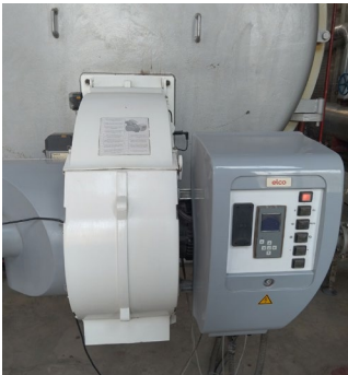
锅炉低氮燃烧器改造
