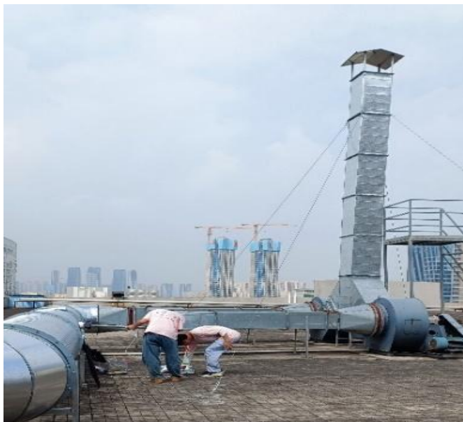
【车间排废管道升级改造】
