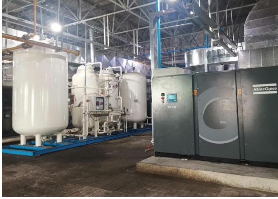
【空压制氮系统改造】
