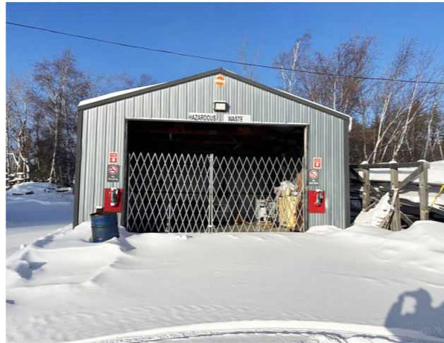
Tanco 危险废物储存和标识
