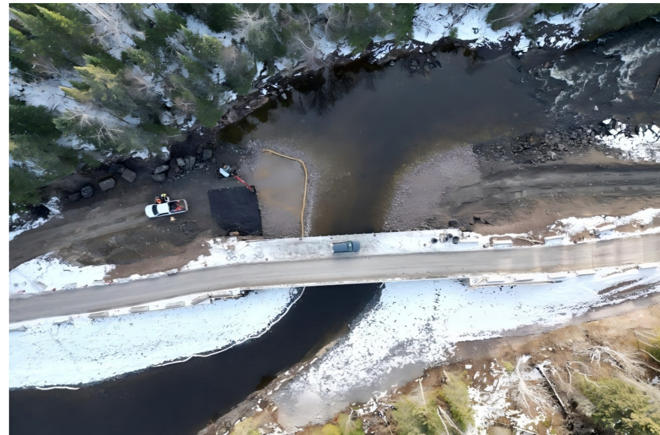
Tanco 矿山大桥
