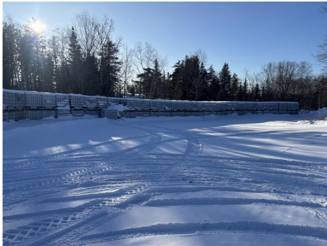
Tanco 固体废物转移站
