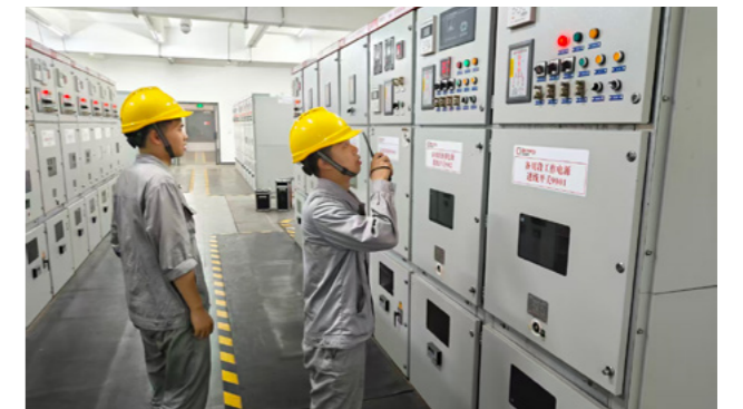
厂用电中断应急演练
