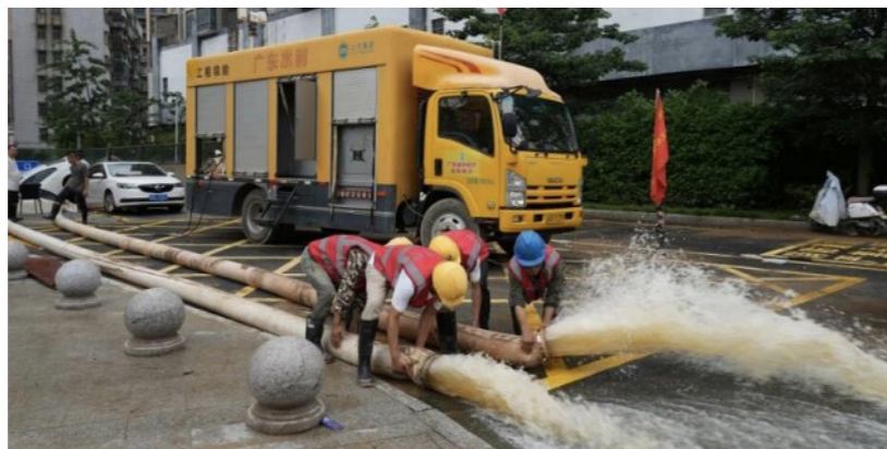
广东水电二局抢险队员正在抢排地下车库积水
