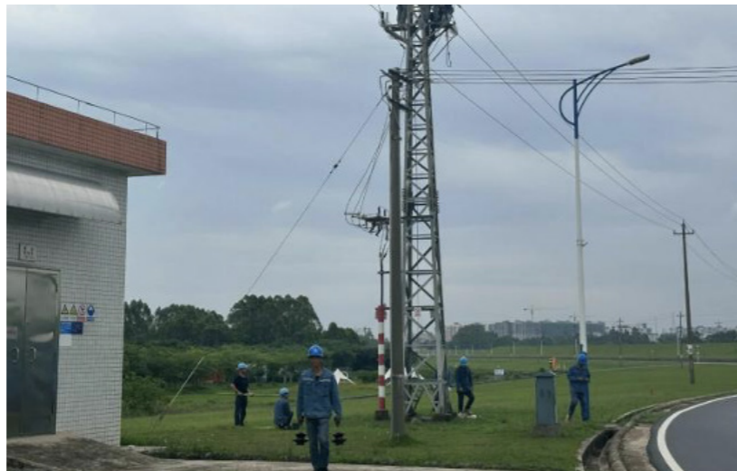
广东源天所属水电公司抢险队正在紧急实施抢修
