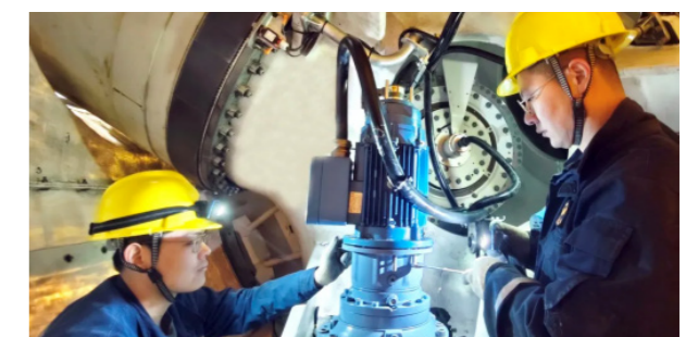
技术人员在风机内开展技术攻坚
