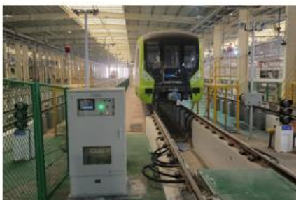
可视化接地验电装置和防误系统
